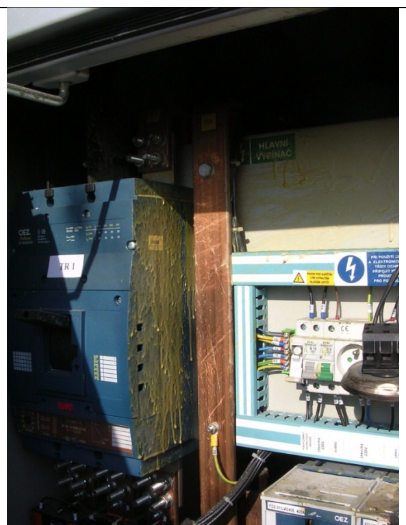
Obr. č. 2 – jistič zapatlaný elektrolytem
